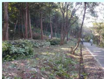
緩衝帯の整備
