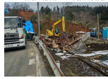
R05.2.17撮影(救助がれき撤去状況)
