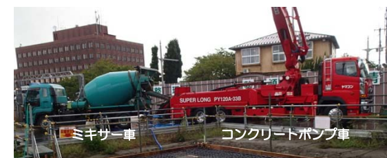
写真：ミキサー車とコンクリートポンプ車
