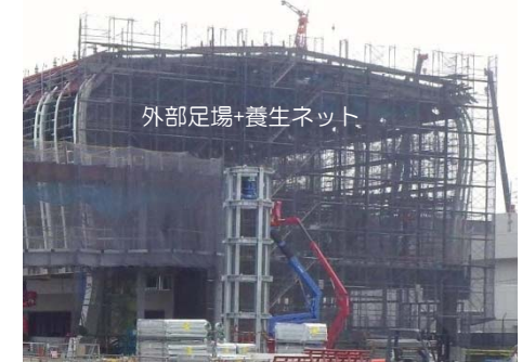
写真：外部足場のイメージ写真
