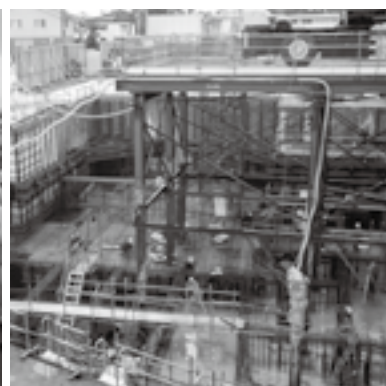
<文化会館工事現場>
