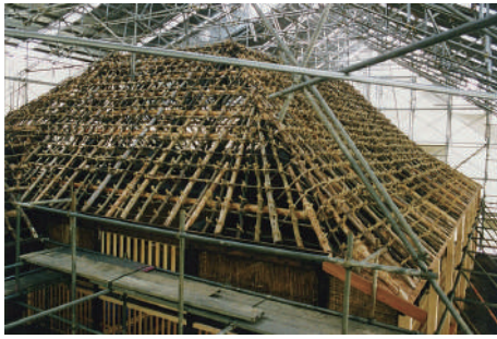
写真 1-5 本陣の保存修理 (平成10年 [1998] ~平成12年 [2000])
