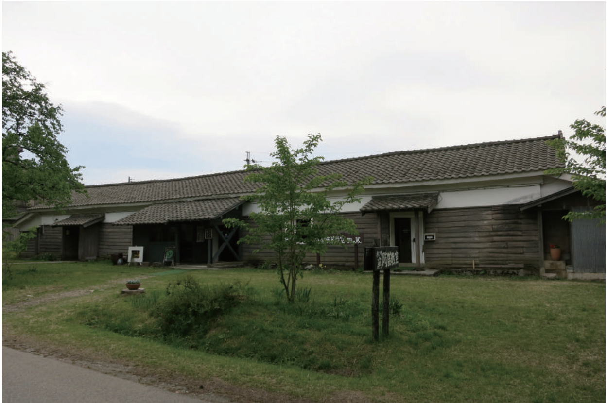
貯桑土蔵（北西より）
