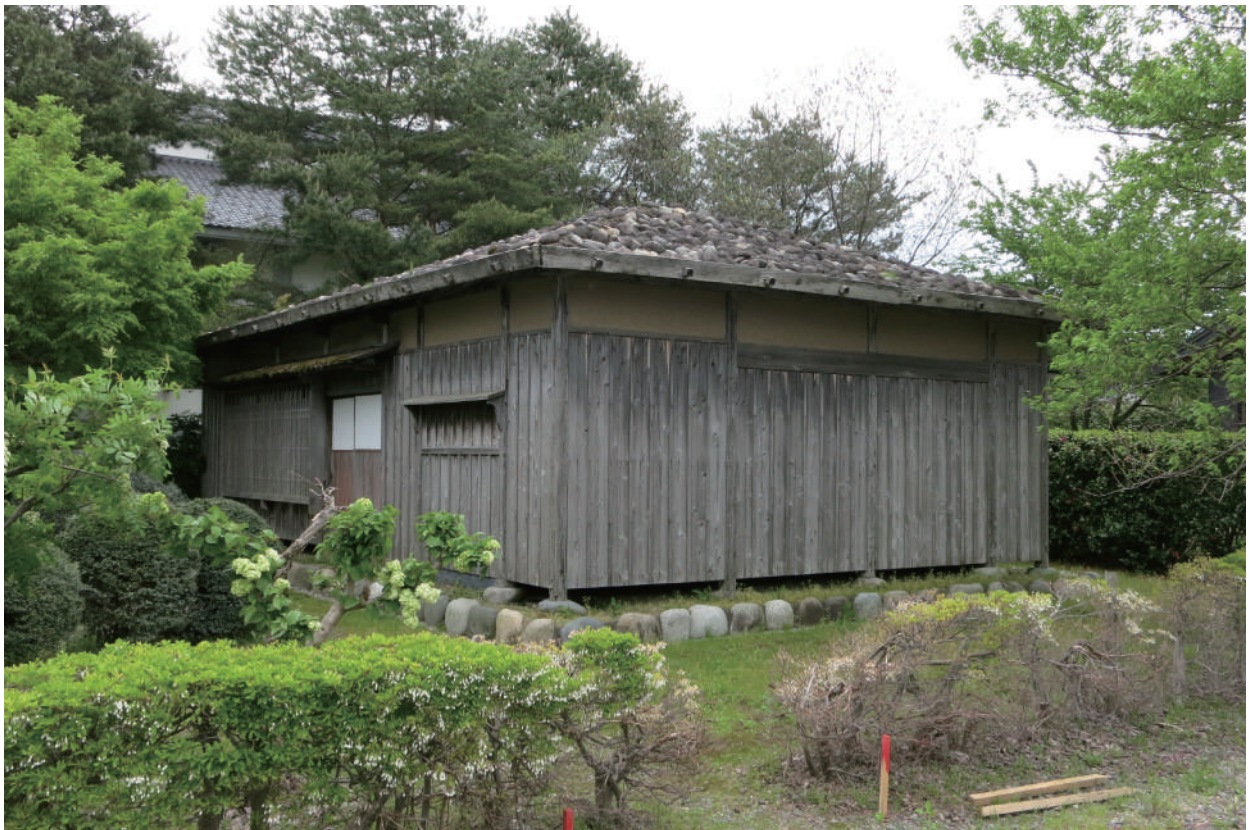
新葺屋敷（北西より）
