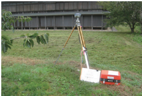
写真 1-9 基礎調査（測量）
