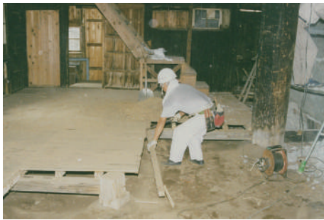
写真 1-6 蚕室 (5番蚕室) の保存修理 (平成13年 [2001] ~平成14年 [2002])
