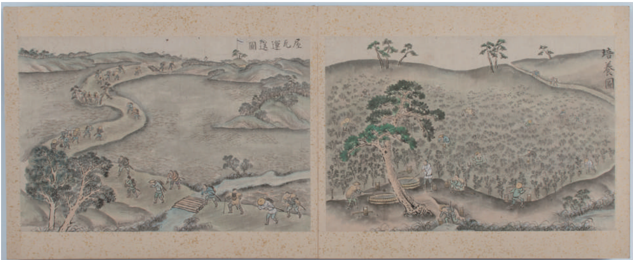
【左】 養蚕のための蚕室を建てる。蚕室は群馬県島村の蚕室をモデルにしたが、規模はそれよりも大きい。その蚕室の屋根に用いる瓦を、鶴ヶ岡城内から松ヶ岡まで運ぶ。6、7歩おきに1人ずつ、あるいは2歩おきに1人ずつ立ってのリレー方式で運ぶことを試みたこともあったが、背負い方式の方が便利だったようで、バンドリや背負い梯子、棒の中央に瓦をぶら下げてなど、それぞれの方法で運んだ。
