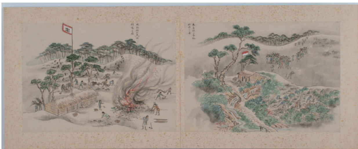
【左】 松の根元を掘り、根を切って幹に網をかけ、大勢でひっぱる。巨木であれば、人が潜って通れるぐらいに掘る。穴の中から見上げると、その根はまるで大黒柱のように見え、木が倒れるときには「太陽も揺れ動き、風の神もたじろぐありさま」だったという。持ち場によっては、巨木が密集しているところもあった。
