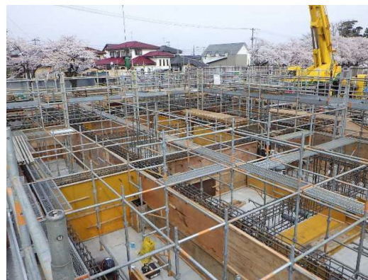
A棟基礎型枠組立状況
