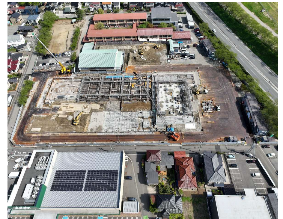
施工状況を上空から撮影した写真です。
