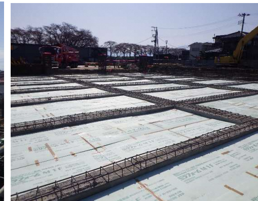
C棟スラブ敷き込み
