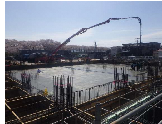
C棟基礎スラブ打設
