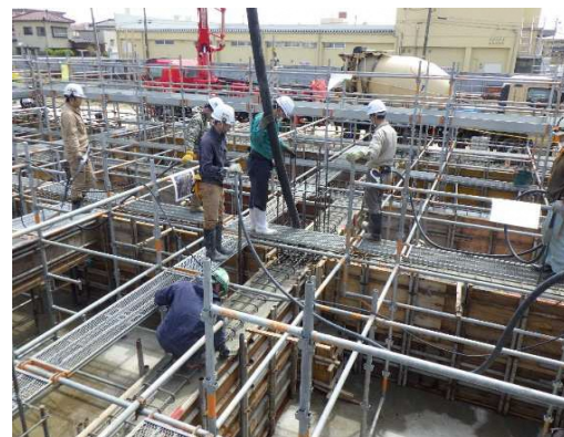
A棟基礎コンクリート打設
