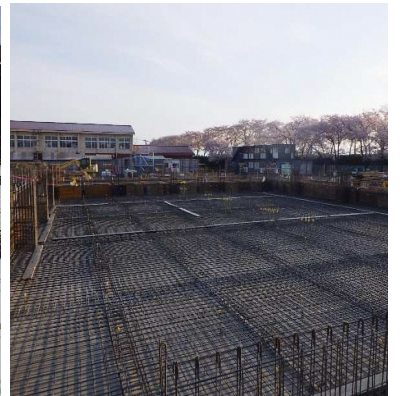
C棟土間配筋状況
