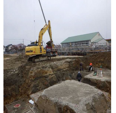
B棟根切り状況
