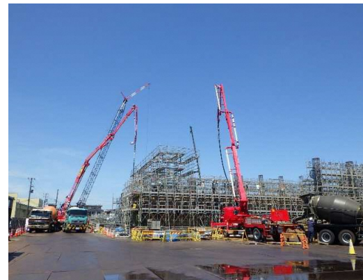
C棟打設状況
