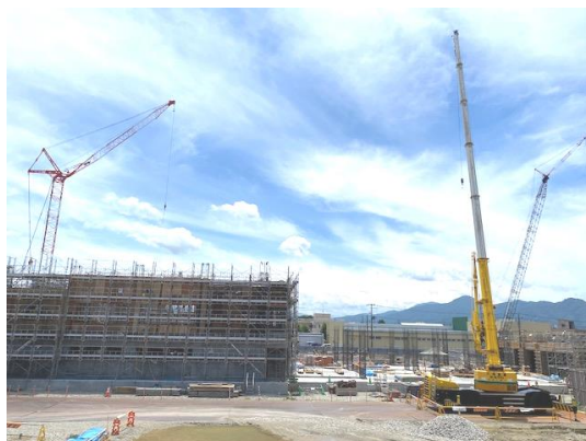
新校舎の2階、3階部分ができてきて、大きさがわかるようになってきましたね。
