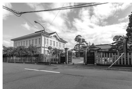
旧東田川郡役所及び郡会議事堂
