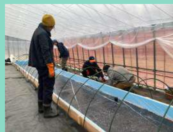
(枠の作成と温床線の設置)
