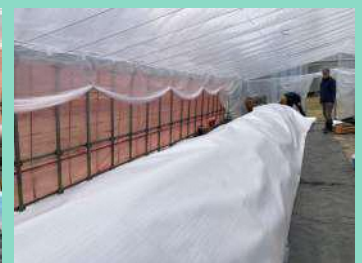
(保温シートをかけて完成)
