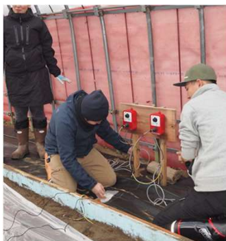
(育苗床を製作している様子)
