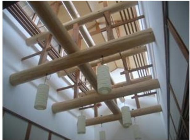
ホールは吹抜け構造で天窗による採光と通風に配慮、伝統木構法の和小屋組で木組みの美しさを強調
