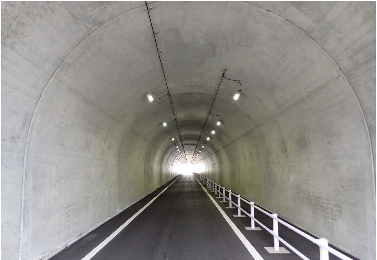
写真：釜谷坂隧道
