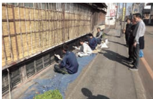
「旧鶴岡ホテル」の外壁補修作業の実施
