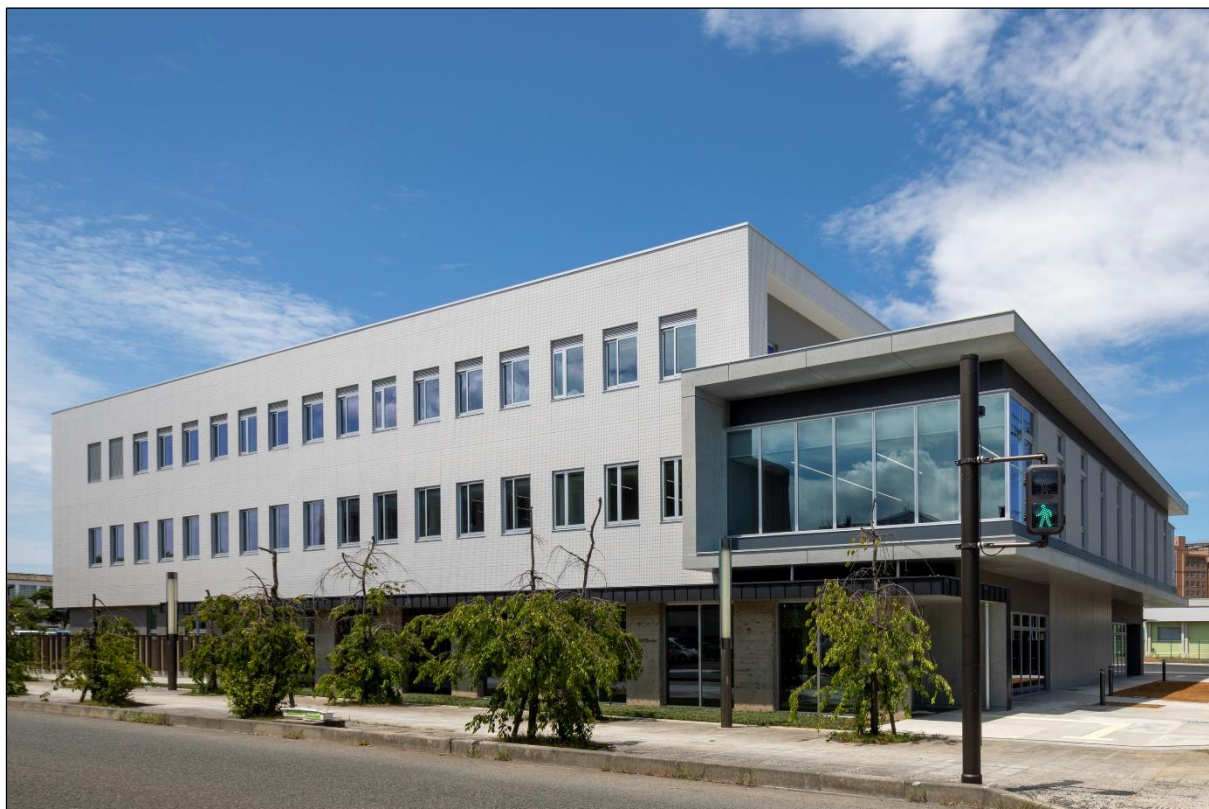
<写真①>庁舎南側外観
