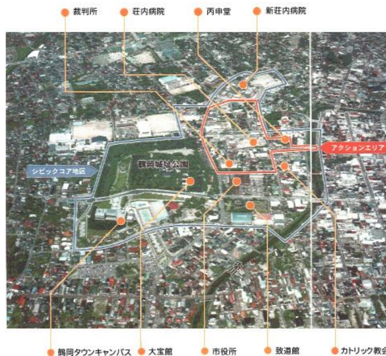
シビックコア地区周辺部の状況
