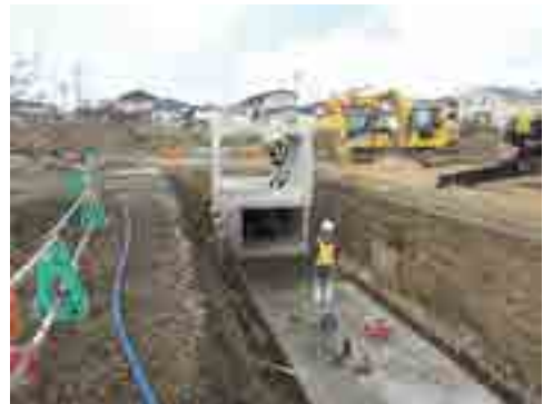
雨水幹線工事状況
