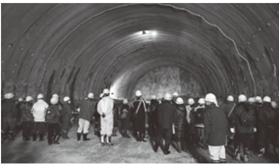
日沿道大岩川トンネル工事現場見学会
