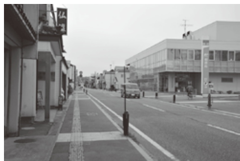
無電柱化が進められた山王通り
