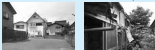
▲神明町地内で実施されたランドバンク事業のモデル事業《写真…右:実施前、左:実施後》
