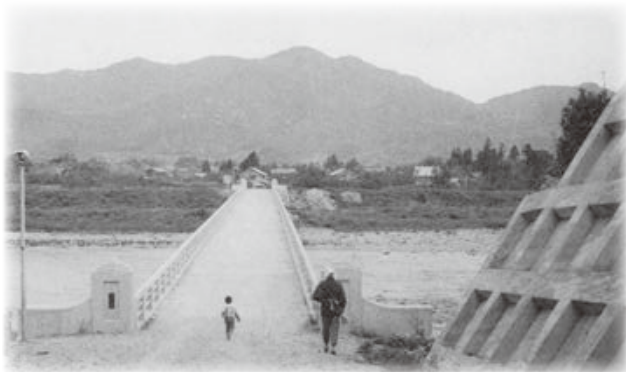
▲旧櫛引橋(松根側から)
