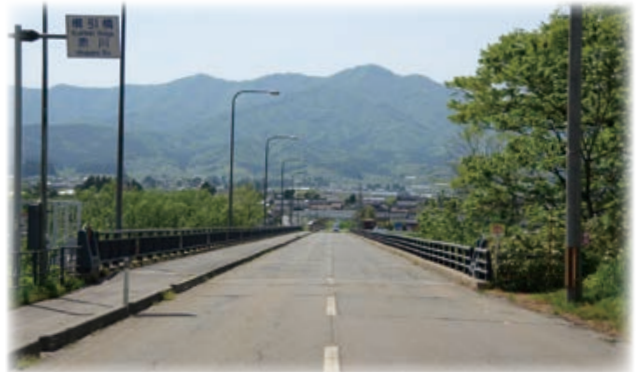
▲現櫛引橋(松根側から)
