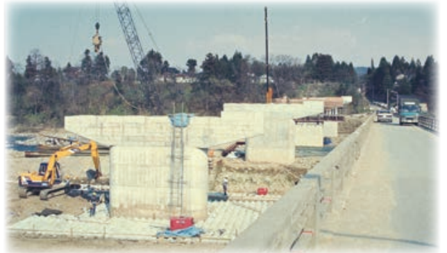
▲現櫛引橋建設中の様子
