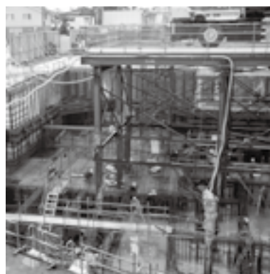
<文化会館工事現場>
