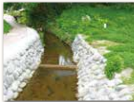
開さく当時から残る石積水路（東昌寺付近）
