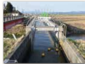
藤島川を横断する水路橋（古郡地内）
