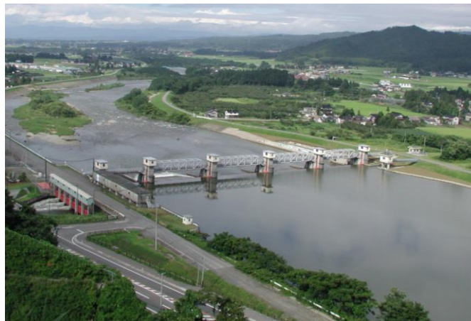
国営事業により改修が行われている赤川頭首工
