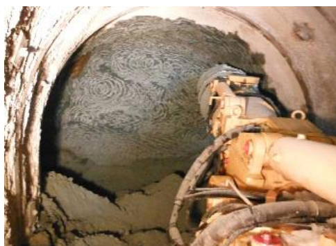
地すべりが止まるように排水対策等を進める（排水トンネルの掘削）
