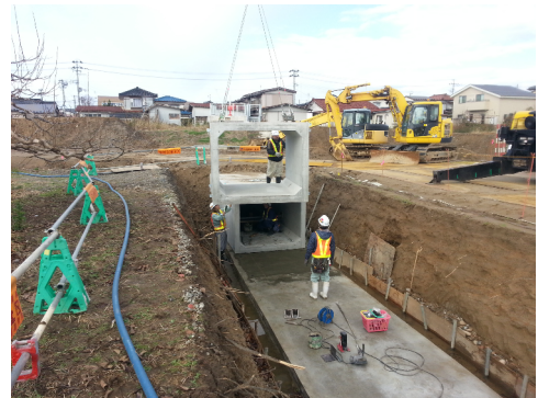
雨水幹線工事状況
