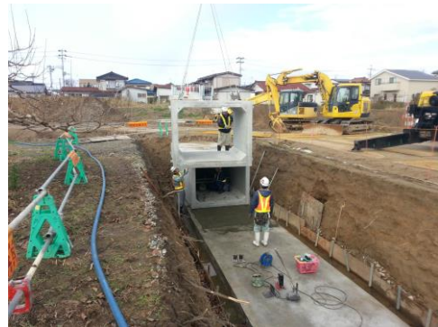
雨水幹線工事状況
