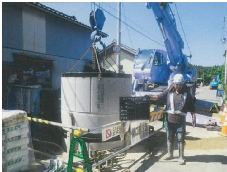
図 1-5 下水道管渠整備状況
