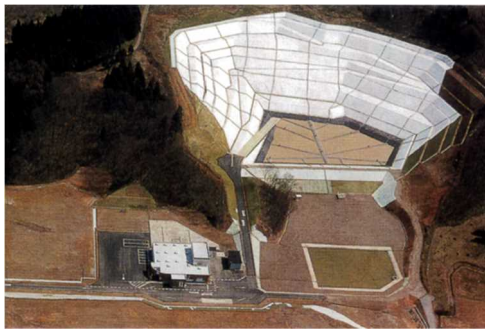
岡山最終処分場（竣工時）
