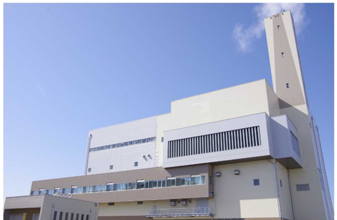
鶴岡市ごみ焼却施設
