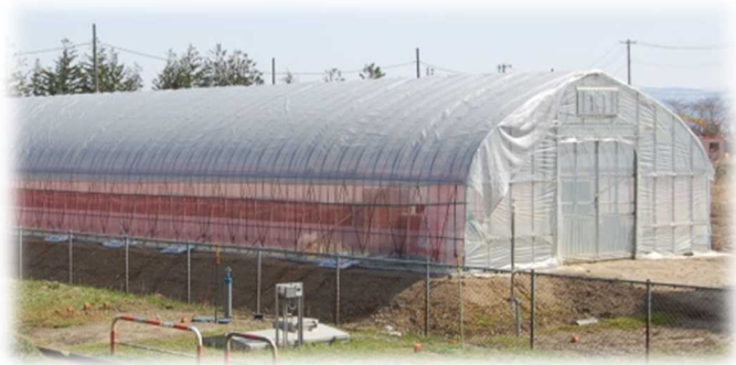
発電余剰熱によるビニールハウス栽培
