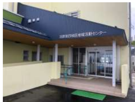
羽黒第四地区地域活動センター整備
