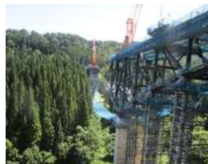
建設中の羽黒山橋(仮称)
