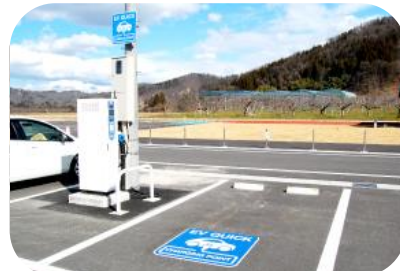
EV充電施設イメージ（山形県朝日町りんごの森）
