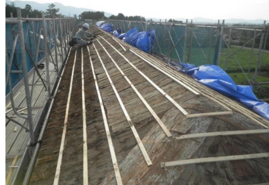
三階屋根瓦棧取り付け
