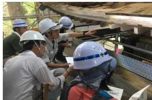
R1.8.3 金峯神社本殿保存修理工事見学会 (参加者39名)
