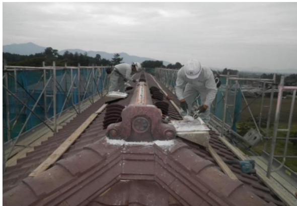
史跡松ヶ岡開墾場 5番蚕室三階屋根根椽瓦葺き 葺き替え工事(作業中)
