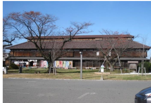
史跡松ヶ岡開墾場 5番蚕室三階屋根根椽瓦葺き 葺き替え工事(竣工)
