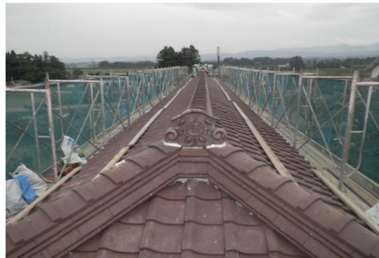
三階屋根大棟瓦取り付け
