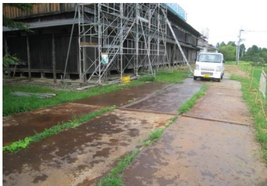
作業用通路と足場架設
