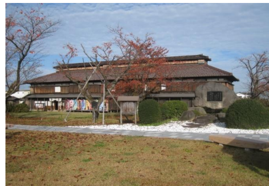
5番蚕室正面(修理前)
