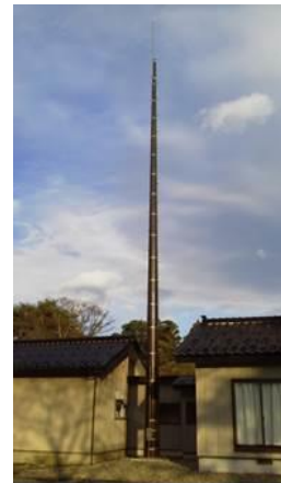
本陣避雷設備 (パンザマスト)の設置
