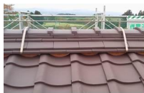
3番蚕室屋根修繕後 及び避雷設備の設置
