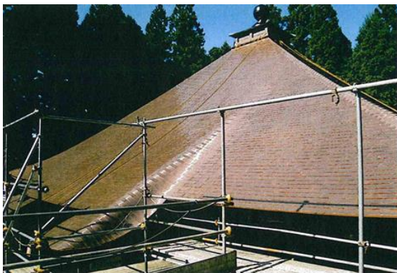
銅版屋根の全面葺き替え
