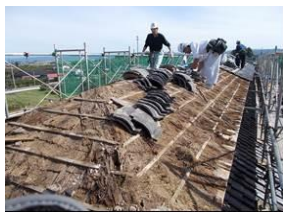
3番蚕室 屋根修繕
