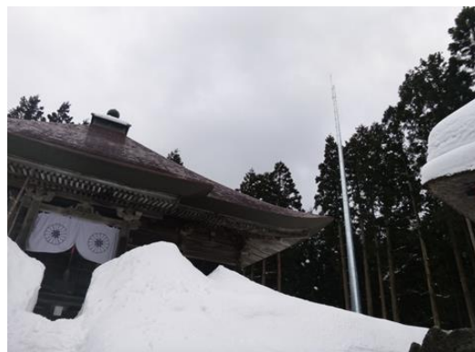
避雷設備(パンザマスト)の設置
