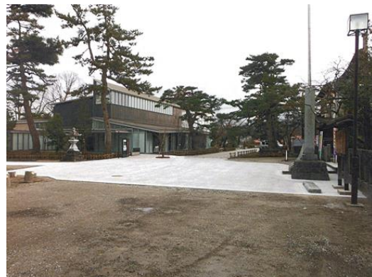
園路整備(洗出しコンクリート舗装)
