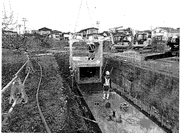
雨水幹線工事状況
