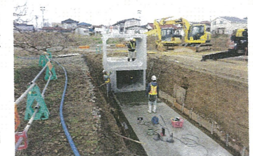
雨水幹線工事状況
