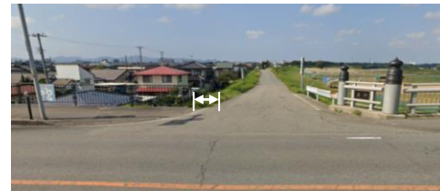
▲進入路拡幅(羽黒橋側)
