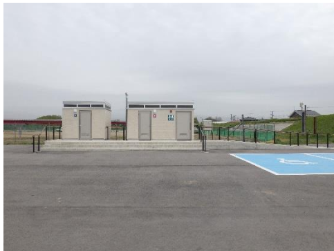
▲トイレ②完成写真
