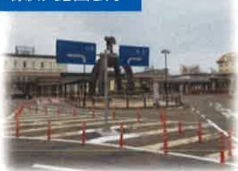
標識・路面表示
