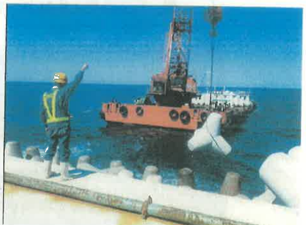
消波ブロック 設置状況
