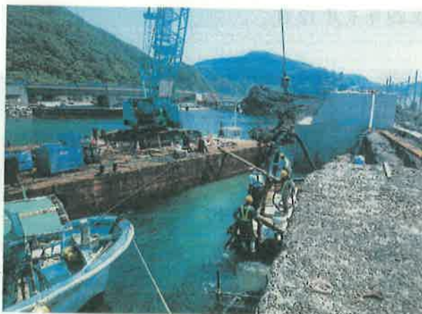
水中コンクリート打設状況
