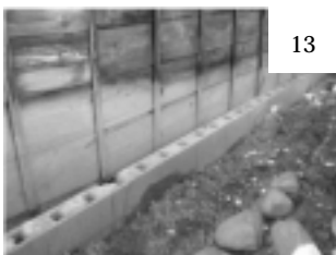
基礎と土台に大規模なずれ
