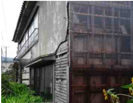
左側壁なし（プラ波板で応急処置）
