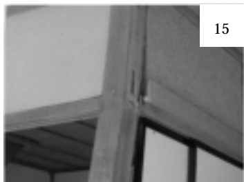
柱の破損
