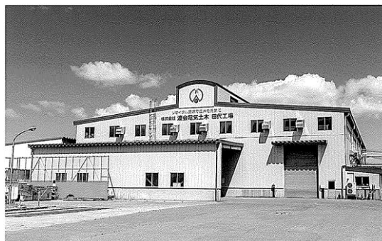
株式会社渡会電機土木 田代工場
