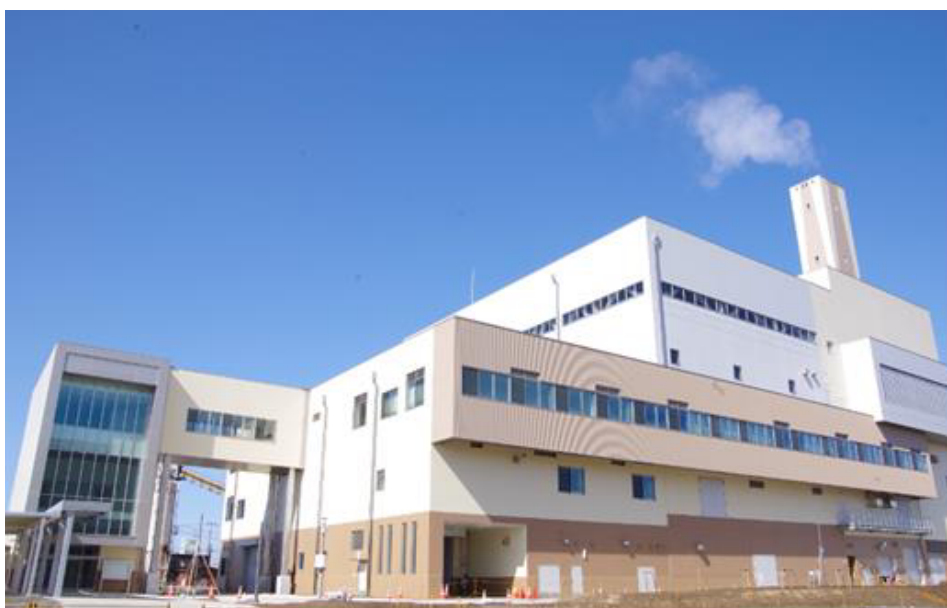
【新ごみ焼却施設（令和3年2月末撮影）】
