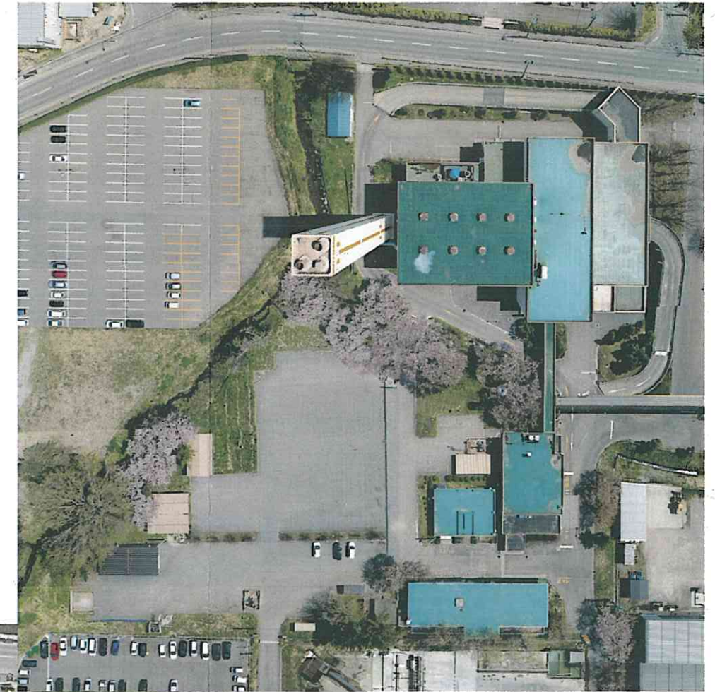
・工事着工前 (平成30年5月)
