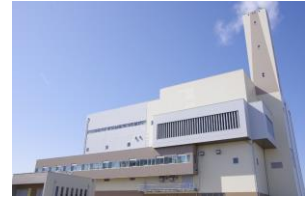
鶴岡市ごみ焼却施設
