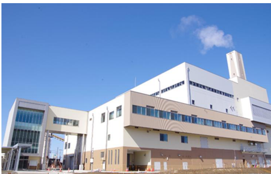
新ごみ焼却施設（令和3年2月末撮影）
