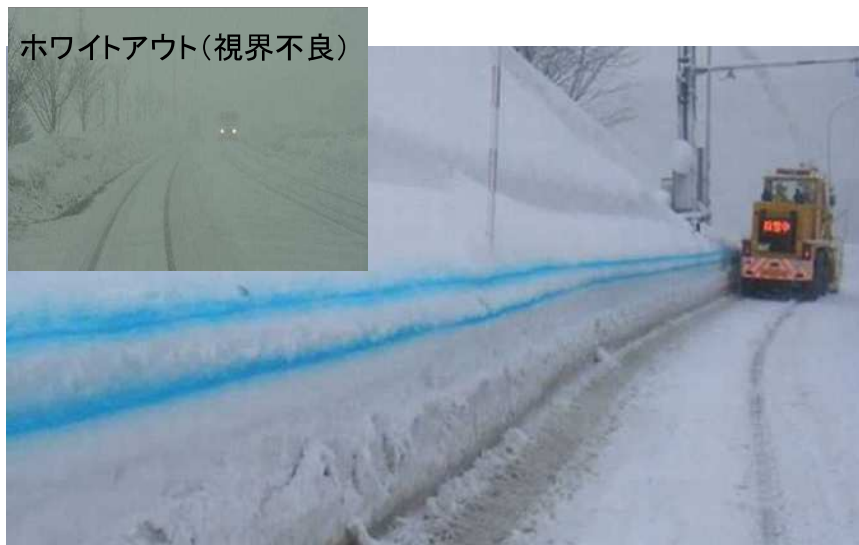
視界不良策として除雪時に雪堤へ視線誘導線を噴霧
