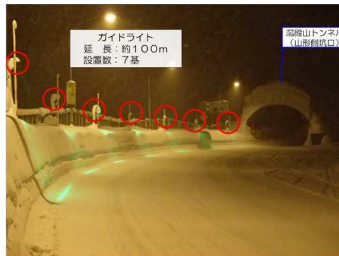
カーブ箇所での視線誘導による事故防止
