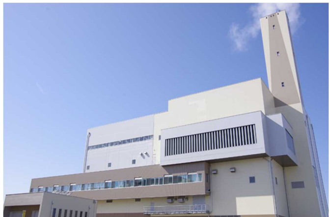
鶴岡市ごみ焼却施設
