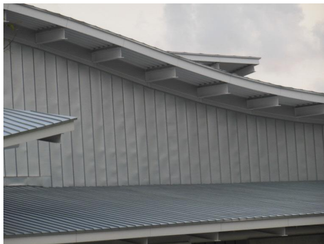
写真-1（鶴岡市文化会館 外壁）
