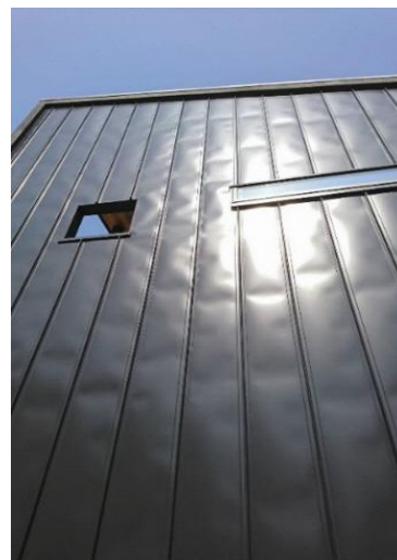
写真-2（都内某個人住宅）
