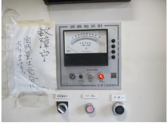
除鉄室(源泉除鉄装置制御盤)
