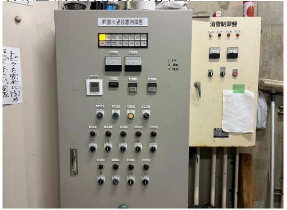
除鉄室(源泉除鉄装置制御盤)
